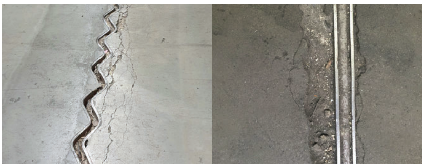
Bild 3 Im Vergleich: Sinusprofil ohne Stabilitätsnachweis und lineares Fugenprofil.
